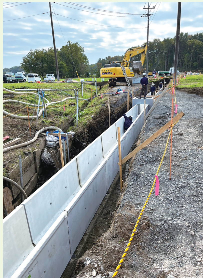
付け替え水路工事
