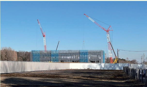
農跡地立地企業の工事風景(撮影:令和7年1月)
